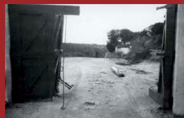
Portão de madeira após o embate
