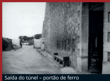
Saída do túnel – portão de ferro
