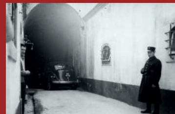
Manobra de marcha atrás no túnel
