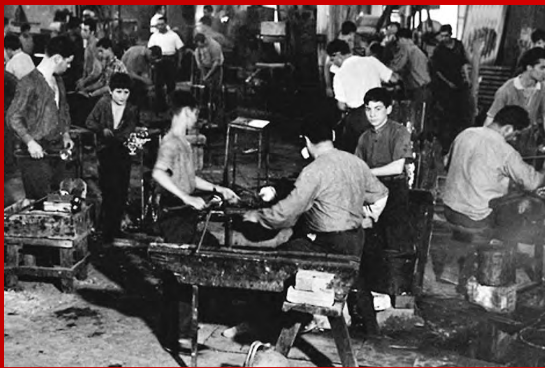
Uma obragem em forno vidreiro
